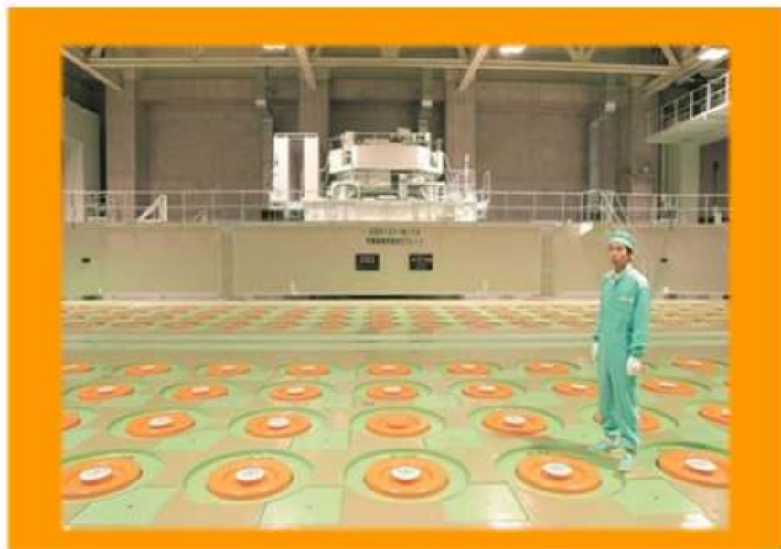
日本原燃(株) 高レベル放射性廃棄物貯蔵管理センター (青森県六ヶ所村) 写真提供: 日本原燃(株)
